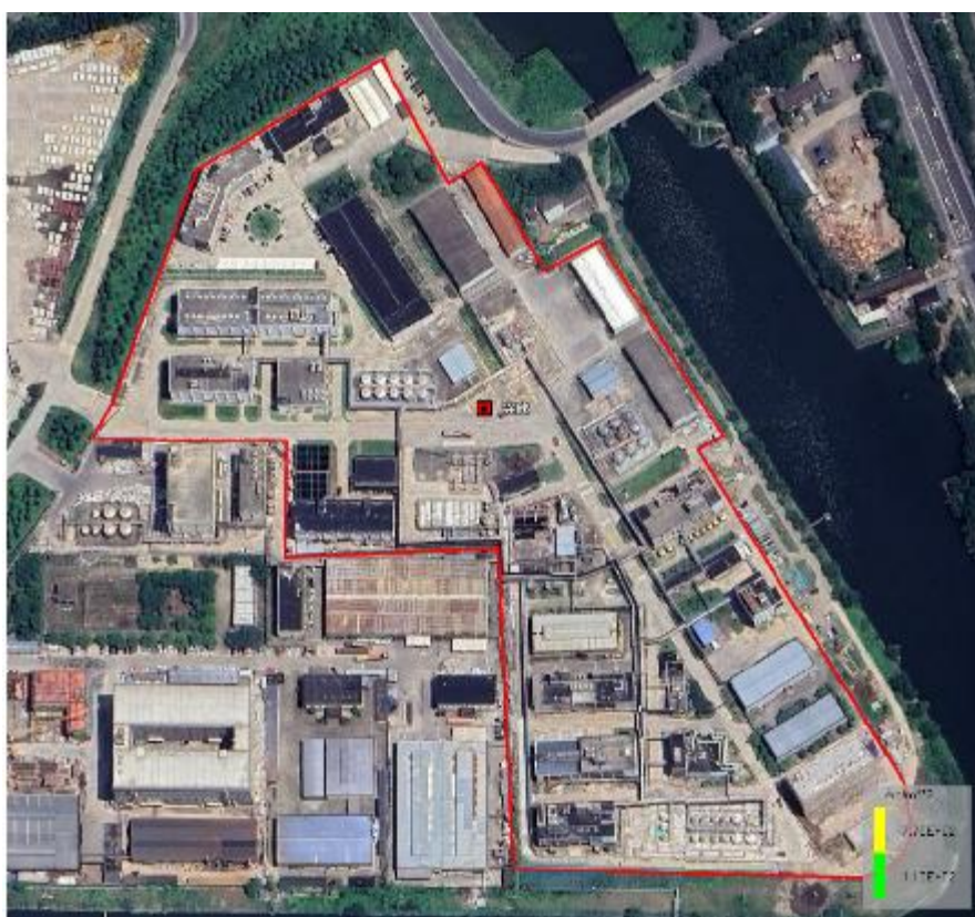
图 7.4-3 最常见气象条件下氨水储罐连接管道破损导致泄漏最大安全距离图
